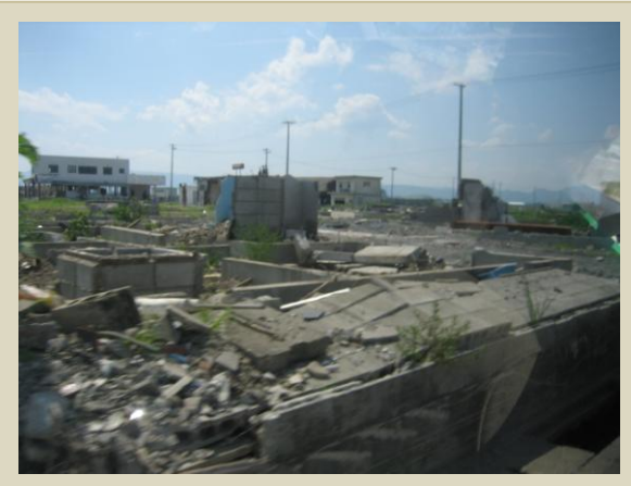
復旧が進まない相馬市の沿岸部
